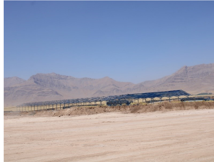
احداث سالن گاو خشک
